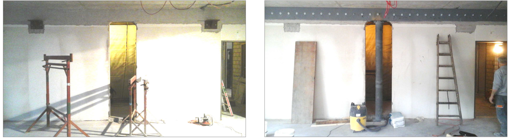
Bauphase: zuerst eine Öffnung, Winkel zur Aufnahme der Metallplatten, Montage der Vollstahlstütze
