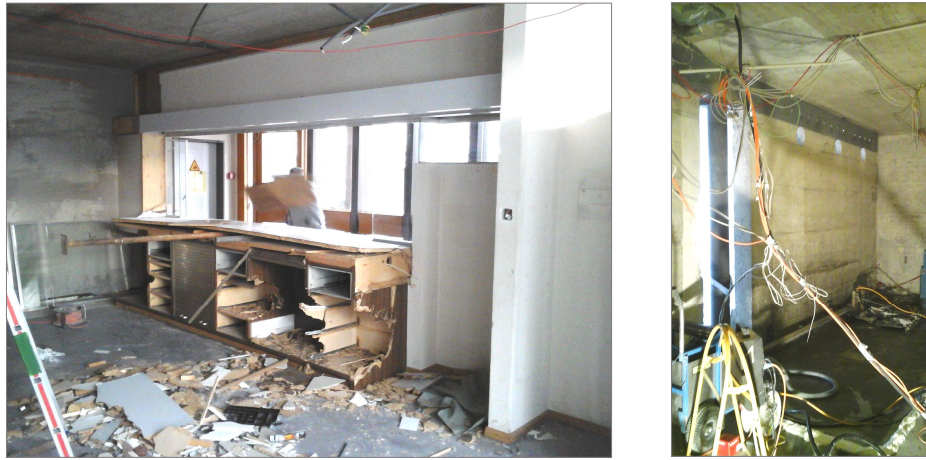
Bauphase: Abbrucharbeiten Schalteranlage mit Trennwänden
